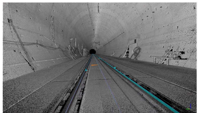
Ergebnis Laserscanning Bahntunnel
